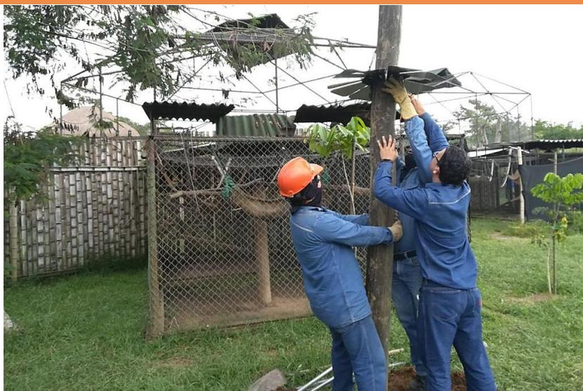
Con esta nueva patente Energía de Pereira quiere evitar que los animales hagan contacto con las redes eléctricas, ocasionando electrocuciones y además fallas en la prestación del servicio.
